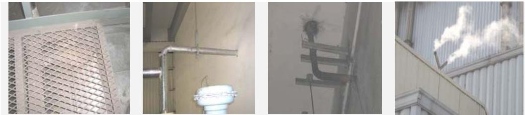
各排气没有支线阀门和节流孔板，在最低点没有疏水口，凝结水无法排出。
