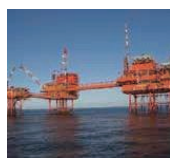
Oil and gas 石油和天然气
