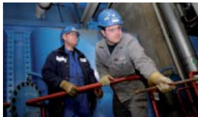
启运瞬间: 拆除凝汽器管道及长度测量
